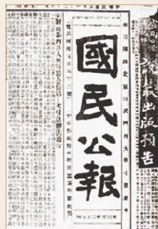
梁漱溟在《國民公報》譴責學生火燒趙家樓
